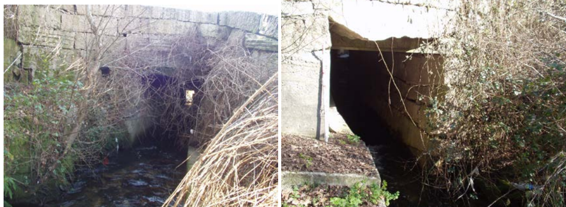
Imaxes da canalización do río na zona da gasolinera que será demolida
